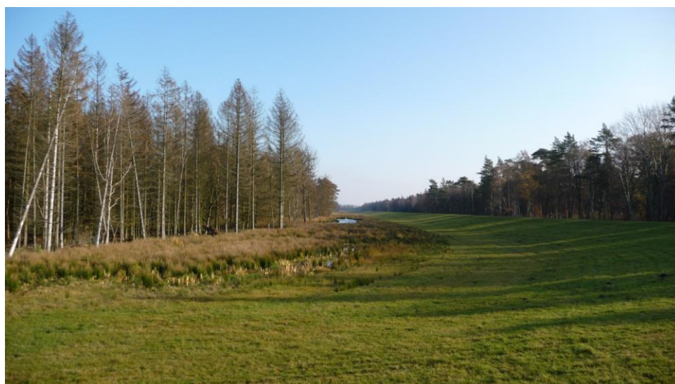
Abbildung 13: rechts: der neu gebaute Seedeich, dahinter der Osterwald; links: das Wasser staut sich von der Ostsee her bis an den Deichfuß heran
