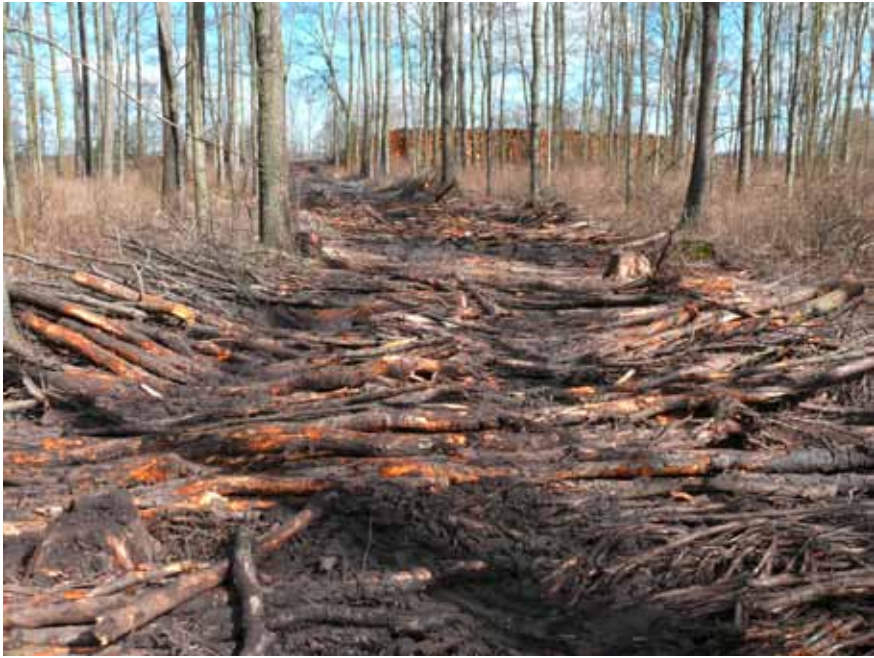
Foto 16: Knüppeldämme aus Durchforstungsholz können in einigen Fällen zumindest für kurze Strecken genutzt werden, um eine Befahrung mit Forstmaschinen zu ermöglichen.
