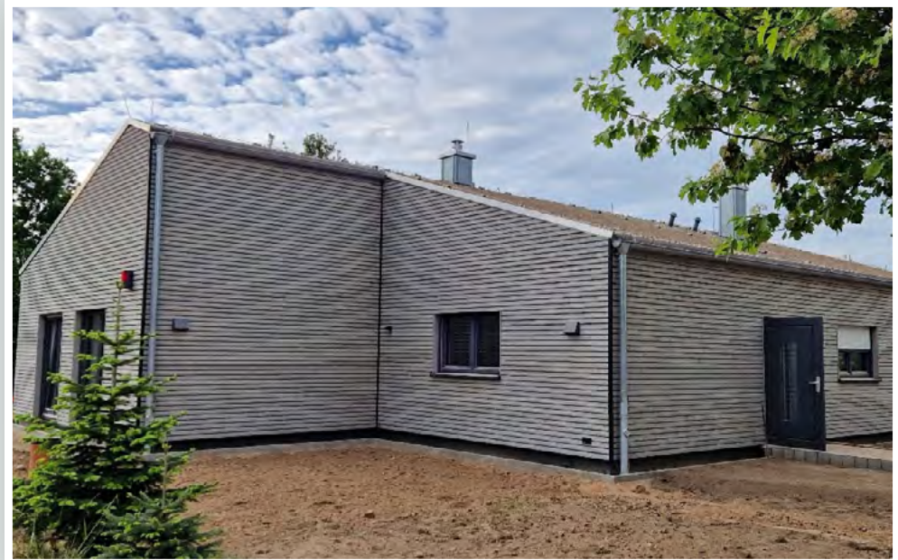
Abb. 35: Erweiterungsbau FoA Karbow in Holzrahmenbau- weise (Foto: Hella Stein)
