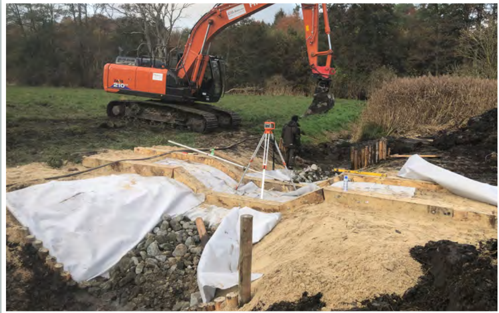
Abb. 32: Herstellung einer Sohlschwelle im Moorschutzprojekt „Lüttwisch“ im FoA Dargun in 2022 (Foto: Falk Jagszent)
