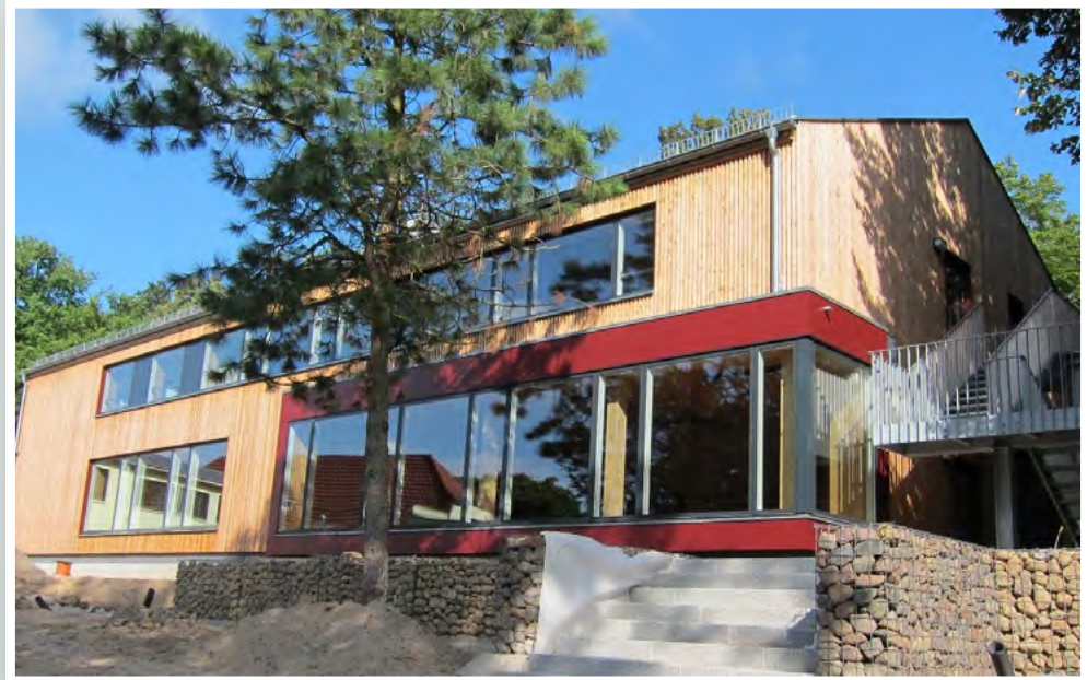
Abb. 34: Ausbildungsstätte FoA Güstrow in Holzrahmen- bauweise (Foto: Hella Stein)
