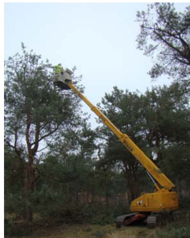
oben: Hubarbeitsbühne im Einsatz rechts: Darre nach Restauration
